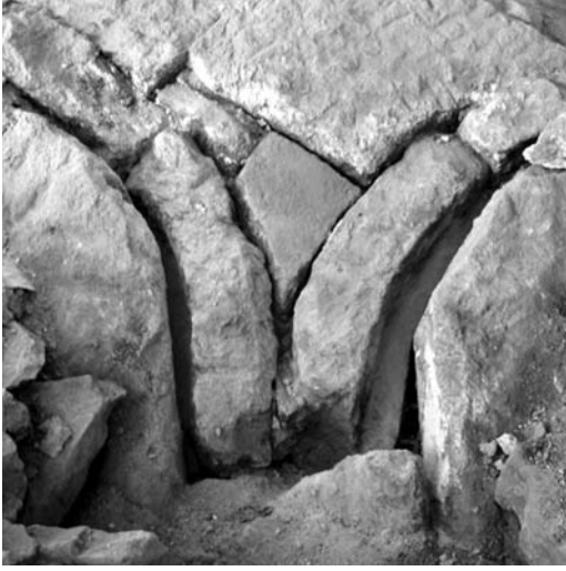
Figure 12 Extrados de la voûte du chœur de l'église de Freixo de Espada-à-Cinta: la queue des nervures courbes est au même niveau que l'extrados des voûtains
